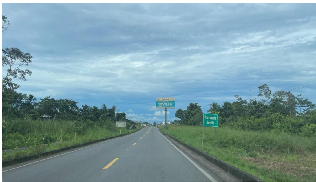
Figura 80 Imagen de vía de acceso a la Cabecera parroquia de Sevilla
