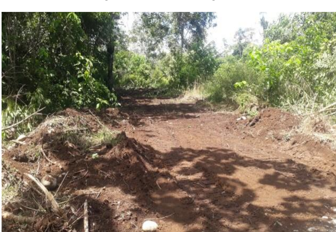
Figura 3 Suelo en la vía al río Aguarico
