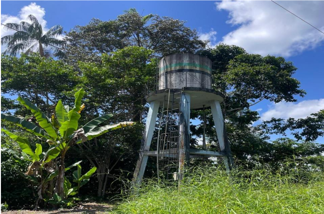
Figura 74 Infraestructura de hormigón armado del sistema de agua en el recinto Manuel Franco
