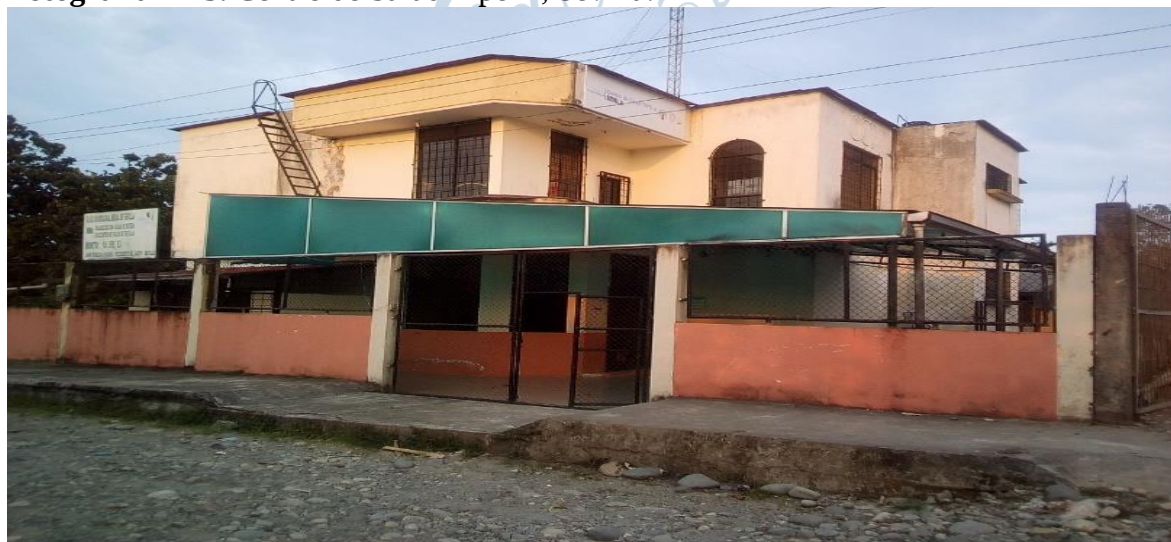
Fotografía N° 5. Centro de Salud Tipo A, Sevilla.
