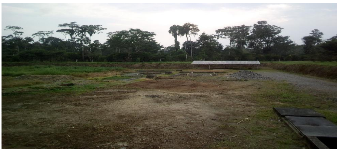
Planta de tratamiento Sevilla.
